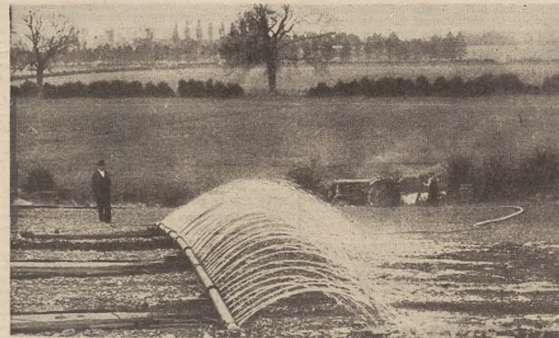
Pomysłowy farmer angielski skonstruował urządzenie, które, puszczane w ruch z pomocą traktora odwadnia z jednej strony teren zalany wodą, z drugiej zaś skrapia rzeźsistym sztucznym deszczem pole. Zdjęcie pierwsze (wyżej) przedstawia urządzenie odwadniające, zdjęcie drugie (niżej)—sztuczne nawadnianie pola za pomocą pomysłowego urządzenia.
