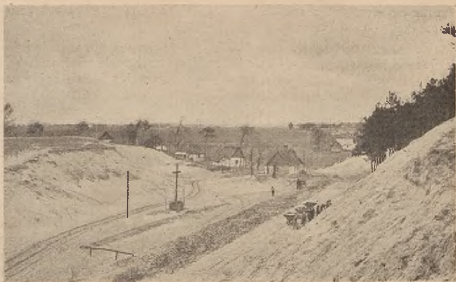
Budowa drogi w okolicach Mielca, prowadzącej do Państwowej Wytwórni Płatowców
