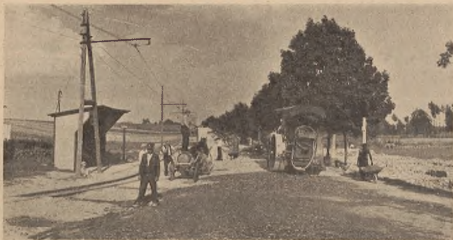
Prace przy budowie nowej drogi
