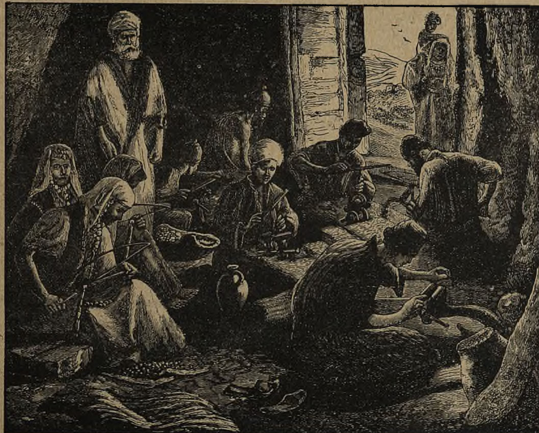
Pracownia perłowej macicy w Betleem.
