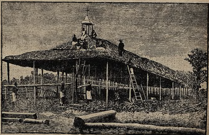
Budowa kościoła przez murzynów.
