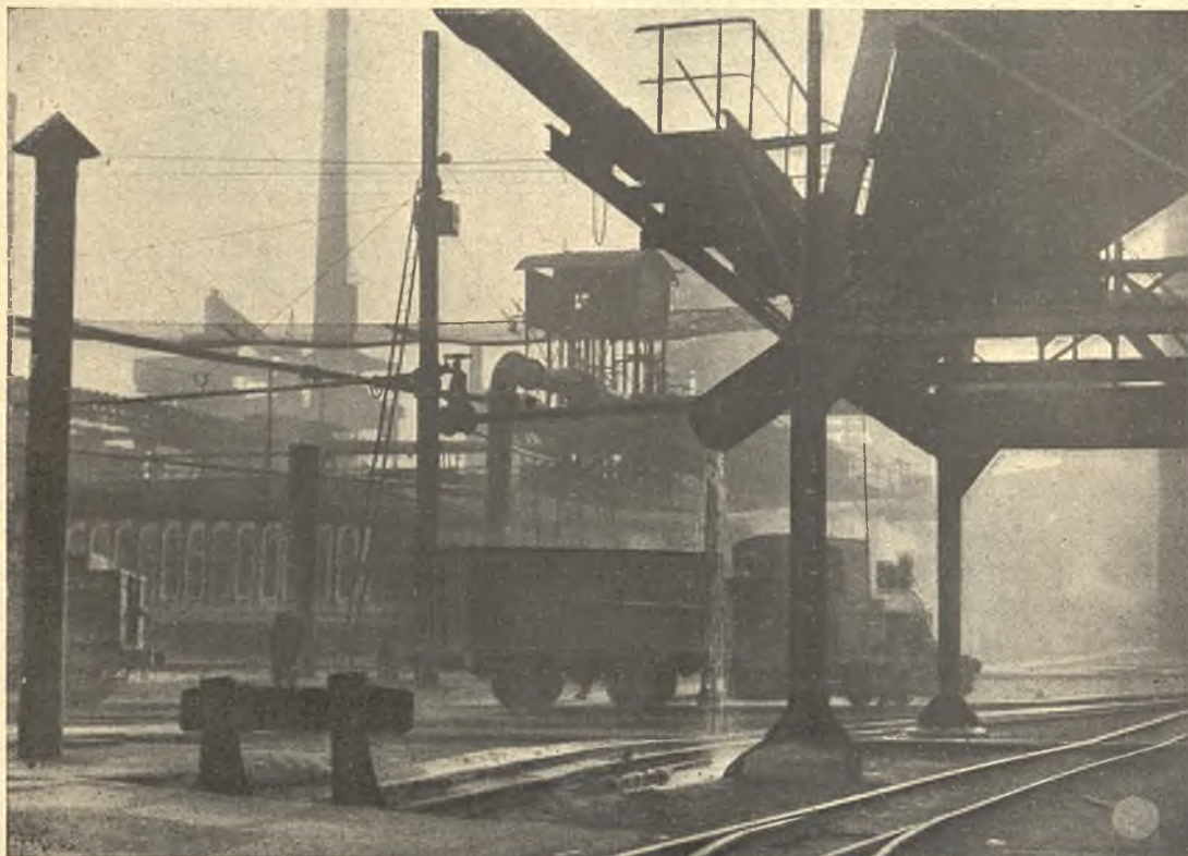
Veduta parziale di una fonderia in Alta Slesia. Fragment z odlewni żelaza na Górnym Śląsku.
