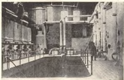
Widok wnętrza cukrowni w Kościanie Veduta dell'interno dello zuccherificio a Kościan (Polonia Occidentale).
