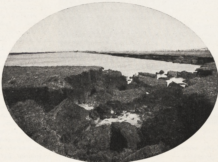
Początkowe stadium robót przy kopaniu basenu portowego.
