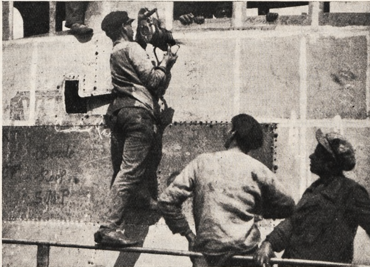
Borowanie dziur i zakładanie nitów w pancerzu łodzi podwodnej
