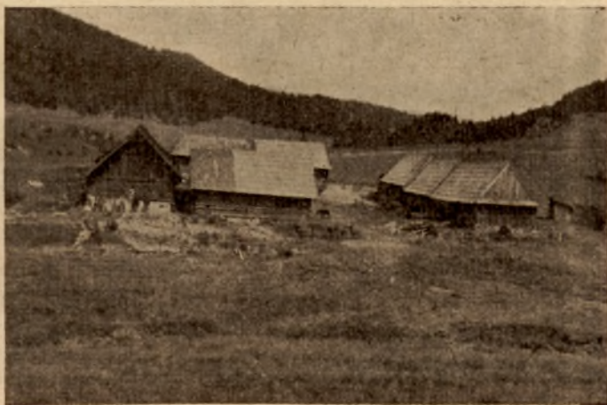
Wodociąg i wzorowe urządzenie na Hali w Dursztynie.
