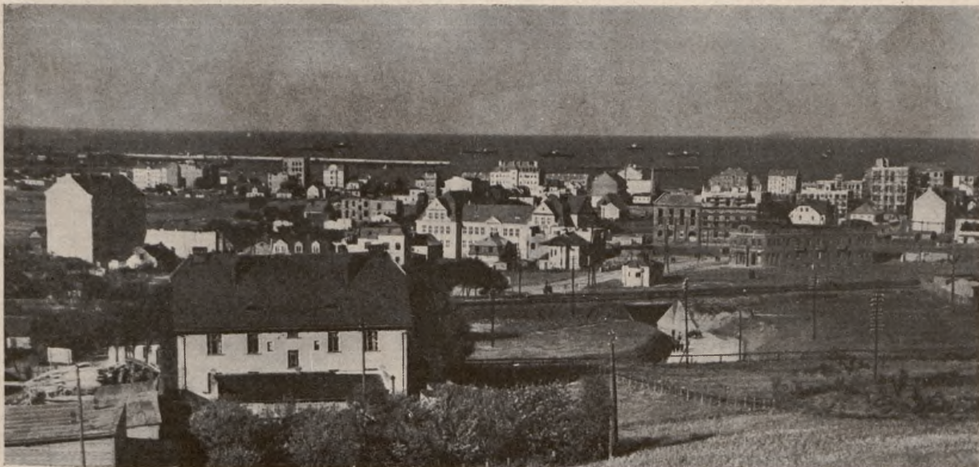
Widok portu Rzeczypospolitej Polskiej Gdyni wraz z częścią miasta. Na morzu widać ożywiony ruch okrętów wchodzących do portu i wychodzących niekiedy do najdalszych kontynentów.
