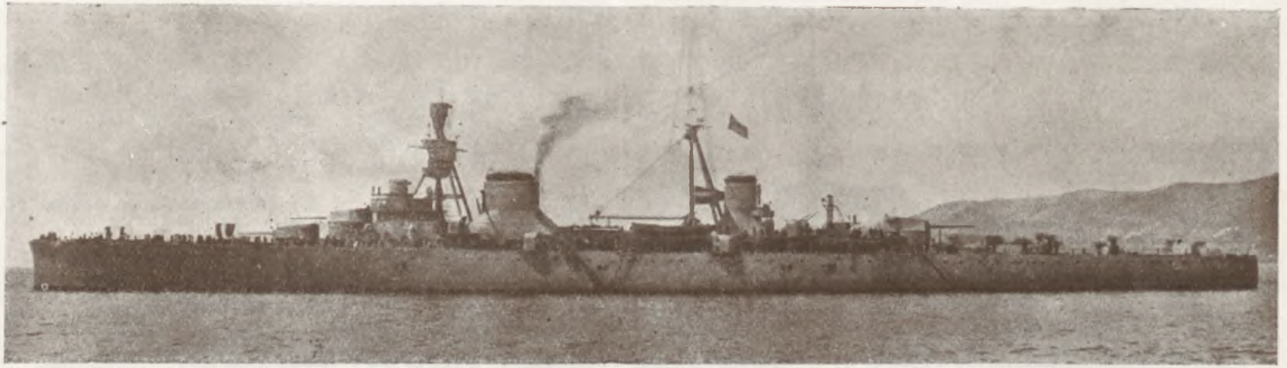
Nowy włoski krążownik „Trieste” (10.000 ton): długość 195 m., szerokość 20 m., zagłębienie 5,75 m., siła 250.000 koni parowych, szybkość 35 węzłów. Uzbrojenie 8 dział o średnicy 203 mm., 16 o śred. 100 mm., 4 mitraljezy 40 mm.
