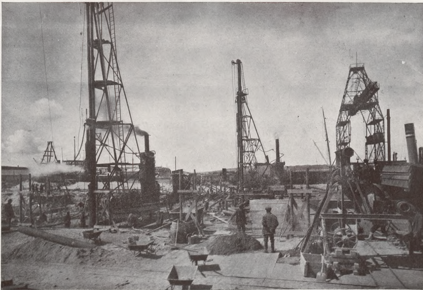
Budowa chłodni przy Basenie Marszałka Piłsudskiego w Gdyni.
