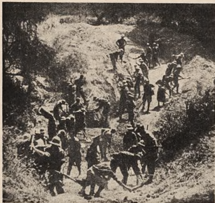
Budowa dróg na nowo zdobytych terytorjach
