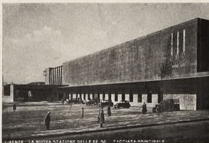
FIRENZE - LA NUOVA STAZIONE DELLE FF. SS. - FACCIATA PRINCIPALE
