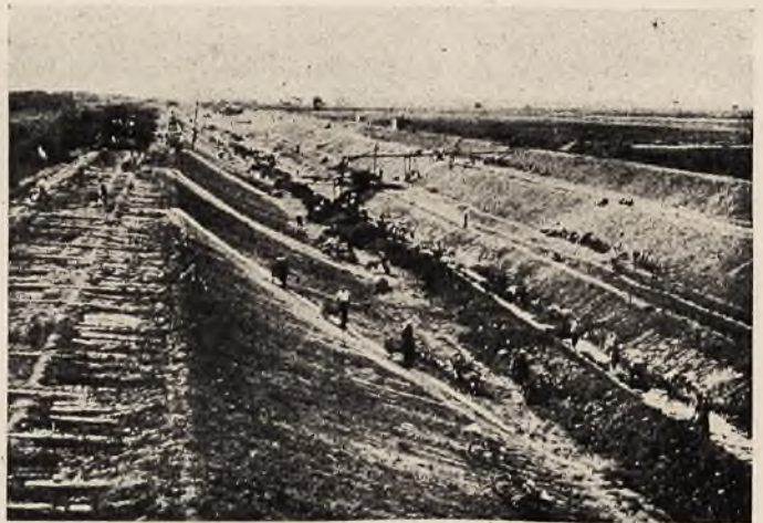
Prace nad skanalizowaniem
