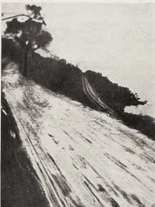
Szosa w miejscowości San Remo a) przed regulacją
