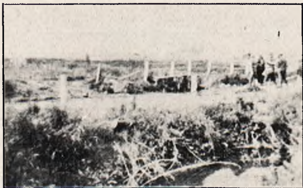
Przed rozpoczęciem prac.
