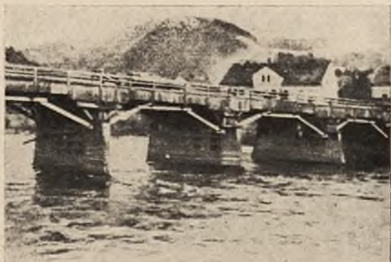
Most widziany z prawego brzegu po wzmocnieniu.
