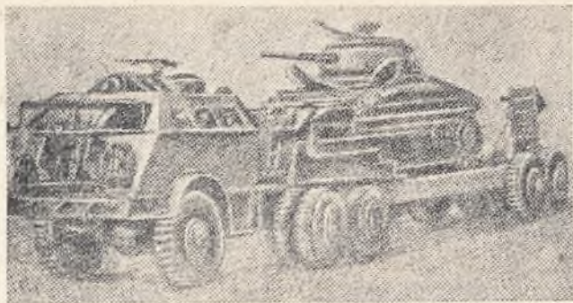
Rys. 1. Amerykański, opancerzony ciągnik połączony z półprzyczepą do przewożenia średnich czołgów
