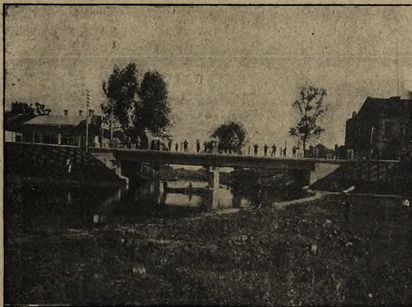
Most żelbetowy w Kowlu. Widok z boku.
