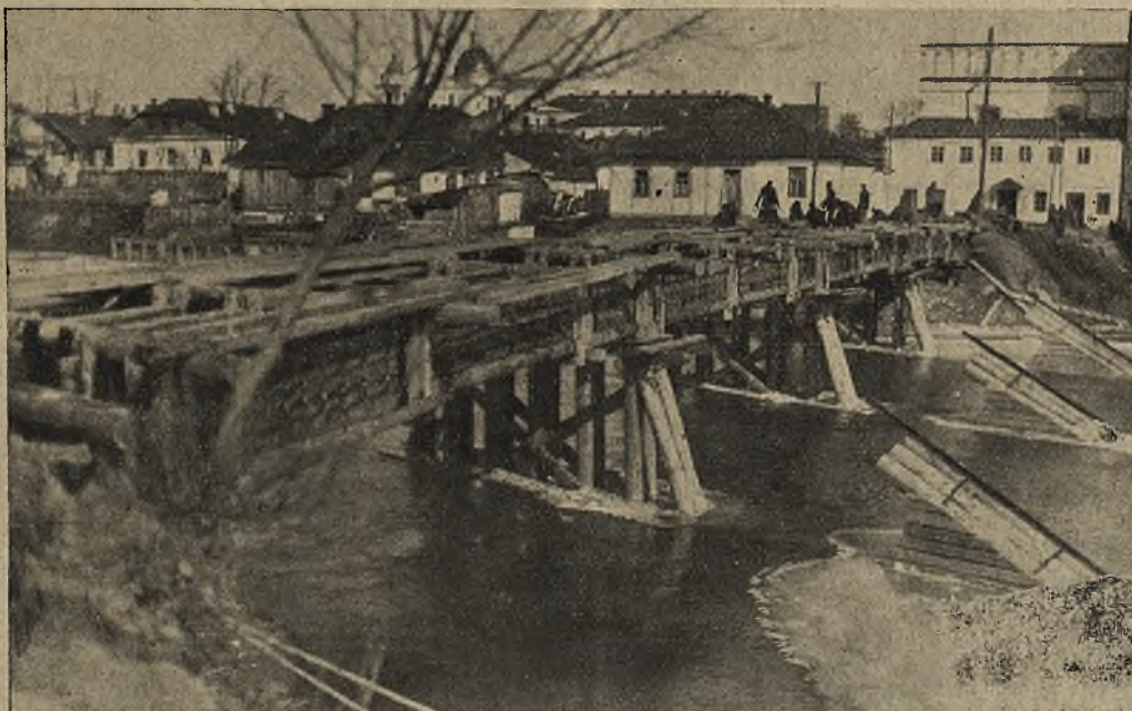
Budowa mostu Hnidawskiego w Łucku.
