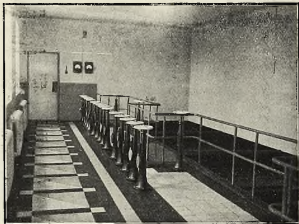
Hala filtrów Wodoc. w Łucku.
