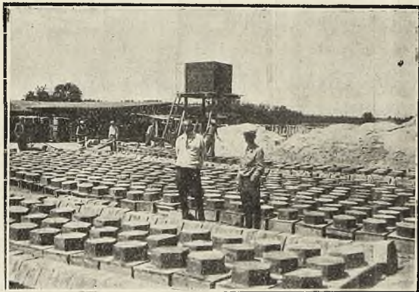
Fabryka płyt betonowych systemu Inż. Trylińskiego.
