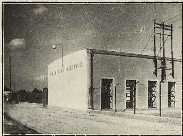
Budynek hali maszyn i pomp Wodoc. w Łucku.
