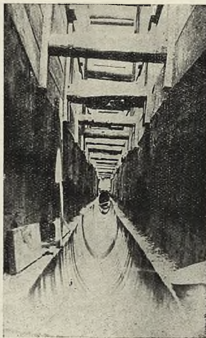
Rys. 9. Kanalizacja m. Łucka.—Budowa kanału 80/140 bitego na miejscu, na ul. Piłsudskiego.
