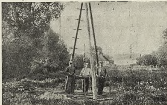
Rys. 12. Wodociąg m. Włodzimierza — Wiercenie studni śr. 3" na terenie ujęcia.
