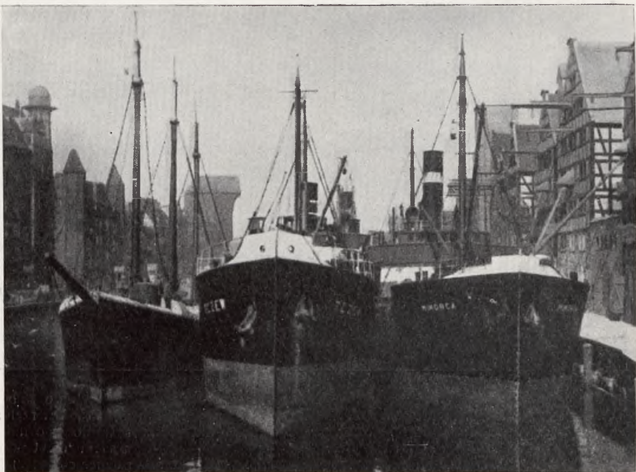
Stary port gdański nad Motławą. Grupa starych śpichlerzy, zmodernizowanych i do- stosowanych do użytku na tak zwanej „Wyspie śpichlerzy”
