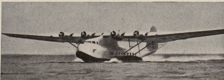
Czteromotorowy samolot „China Clipper” o sile 2000 CV przebywa 5000 kilometrów nad Oceanem Wielkim z szybkością przeciętną 255 klm. na godzinę, z 12 pasażerami i 5 ludźmi załogi
