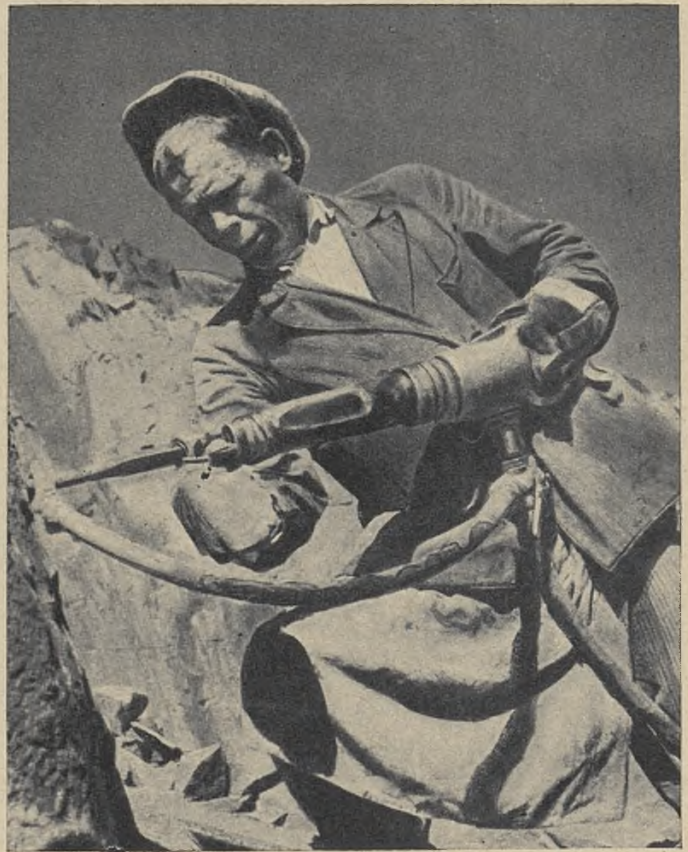
Prace nad wydobywaniem diabrazu w okolicy jeziora Onegi (Karelja) w rejonie szeltozijskim. Robotnik o rekordowej wydajności pracy (udarnik) wierci otwór w celu założenia miny i rozsadzenia skałuby.
