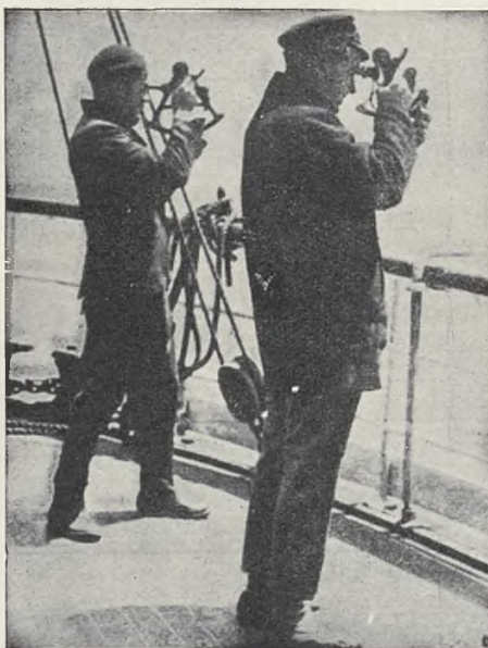
Marynarze za pomocą specjalnego przyrządu (sekstans) i czasomierza określają długość i szerokość geograficzną, pod jaką znajdują się na morzu. Oto nastawianie instrumentu na skraj horyzontu i brzeg tarczy słońca
