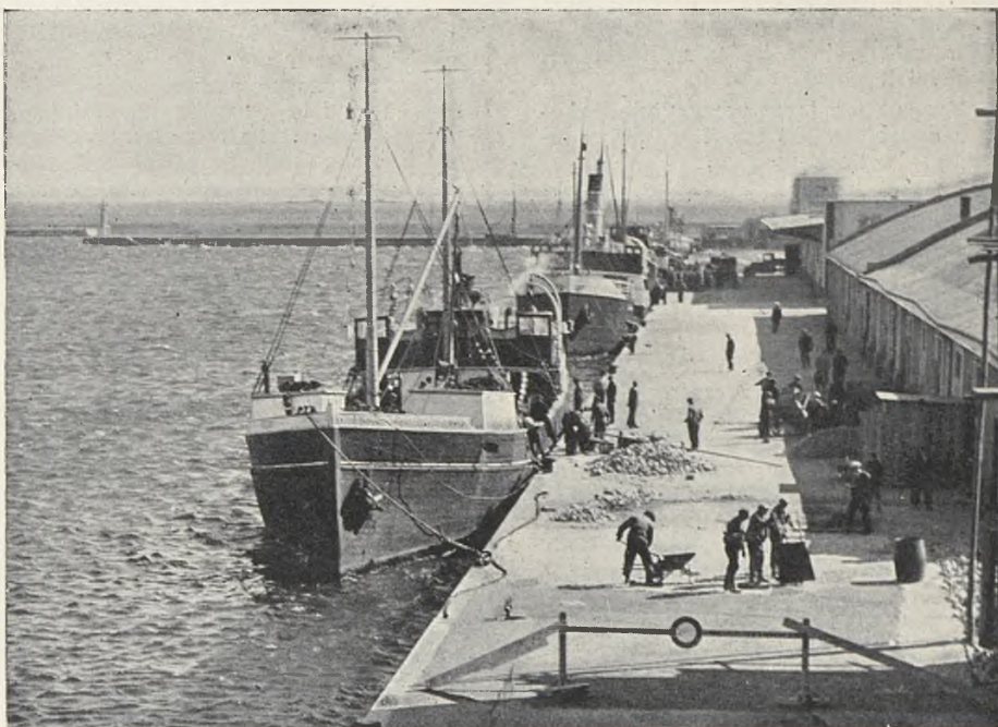
Budowa nawierzchni w porcie Gdyni (biuro techniczne A. Przybylski)
