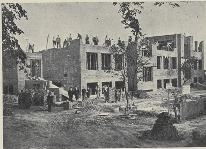
Budowa szkoły powszechnej w Koszęcinie.
