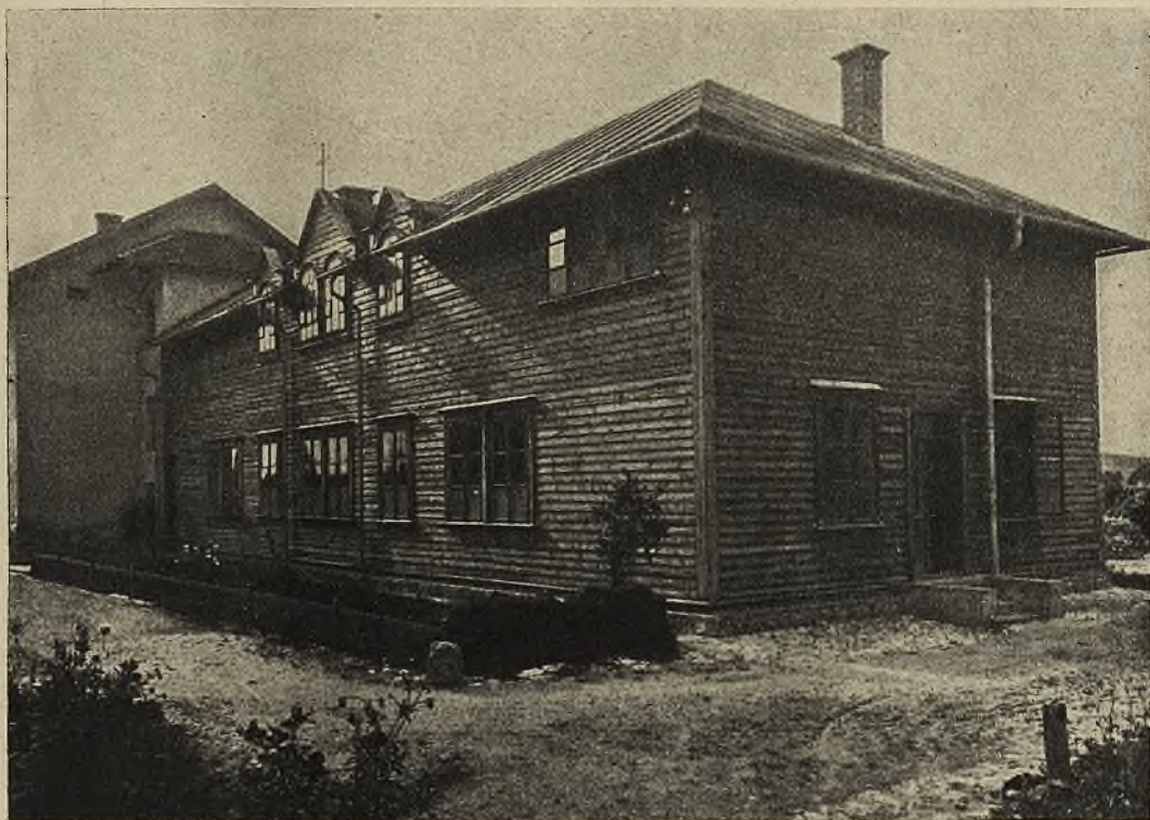
1. Drewniany budynek Kolegium Księży Salwatorjanów w Krakowie, na Zakrzówku.
