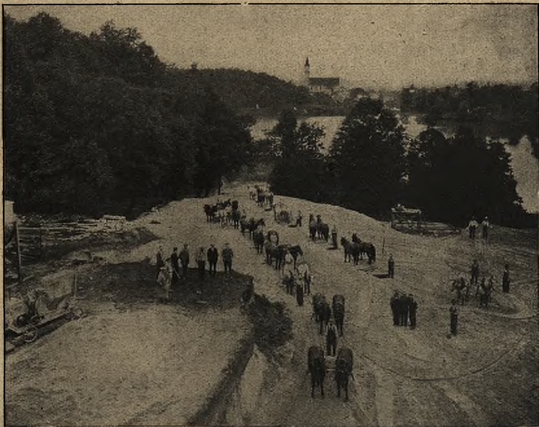
Budowa Kolegium w St. Nazianz. W tyle jezioro należące do Towarzystwa i Kościół parafjalny.
