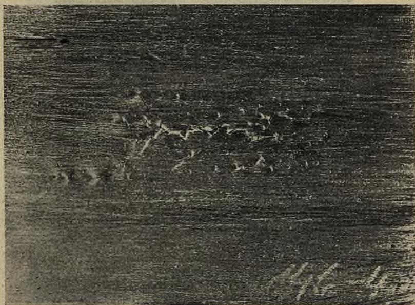
Fot. 11. Płytkę poprzeczną z rygla 100 \times 100 mm hartowaną i odpuszczaną. Widać po zgięciu rysy.
