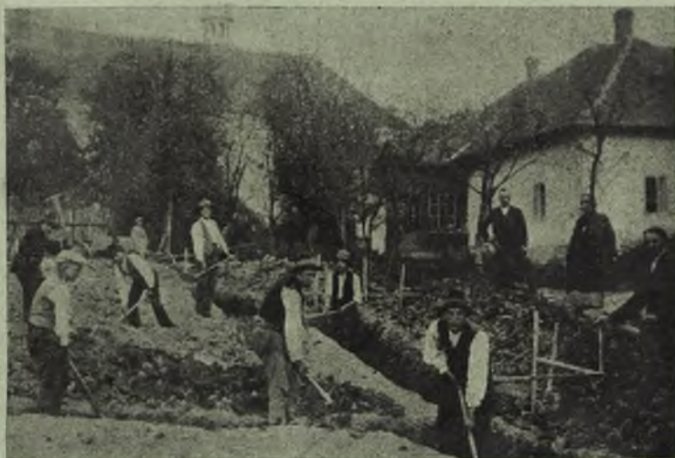
Budowa „Domu Parafialnego” w Tymbarku. — Druhnowie przy pracy.
