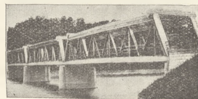
Most na Sanie pod Leskiem.
