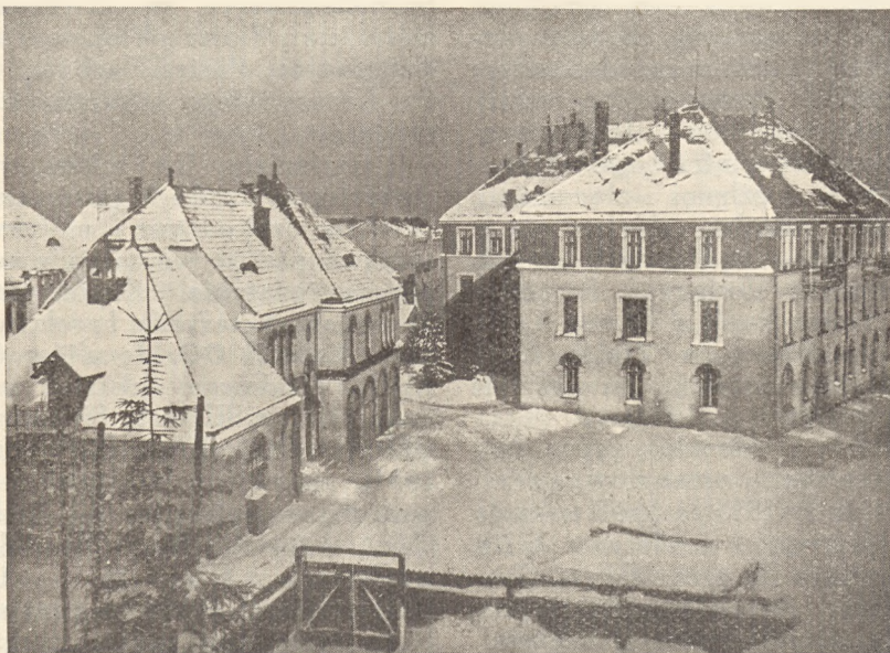
Gmach dyrekcji Zakładów Wodociągowych m. Lwowa. (Do art. na str. 33).
