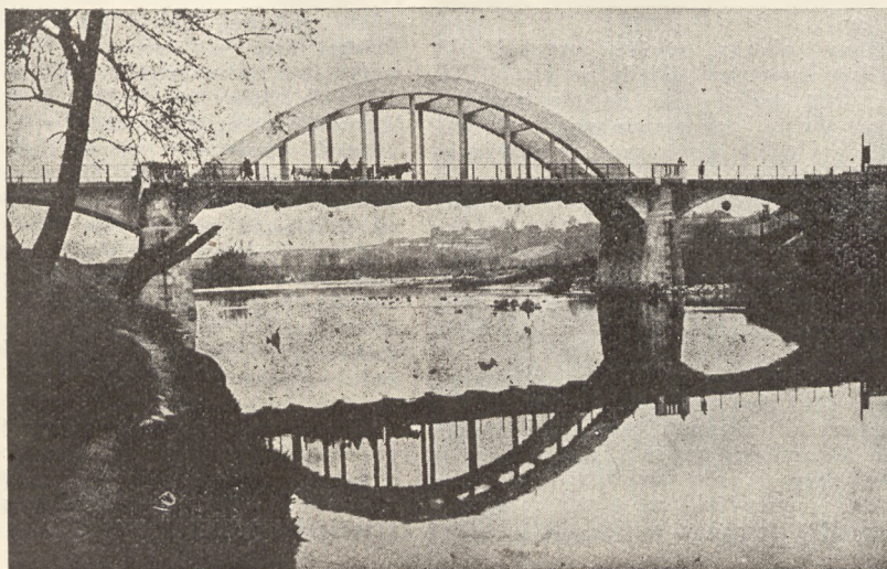
Rzeszów. Most na Wisłoku.
