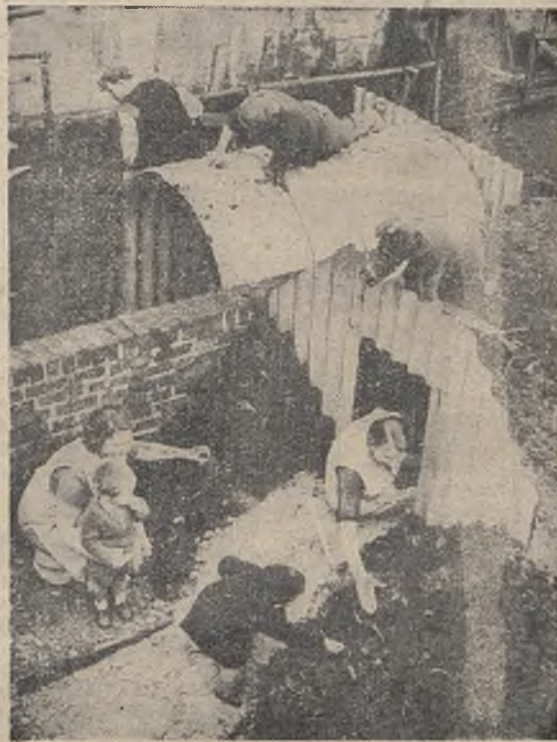
W Anglii robotnicy budują sobie schrony przeciwlotnicze we własnych ogródkach.
