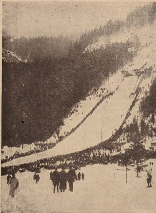
Skocznia narciarska w Zakopanem.
