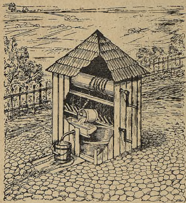
Studnia z kubłem opróżnianym wewnątrz odbudowy.
