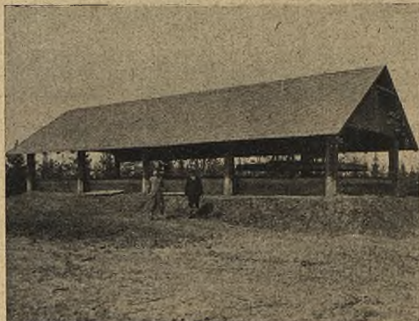
Ryc. 7. Dach nad baterią zbiorników Morawia, dla ochrony przed słońcem i przed zaciekaniem.
