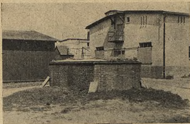
Ryc. 6. Zbiornik z przykrywą z cegieł w stacji doświadczalnej w Czechnicach (Kraiborn) koło Wrocławia. Wieko przykryte jest słomą dla ochrony przed promieniami słonecznymi. Kit łączący cegły okazał się nieuszczelny.
