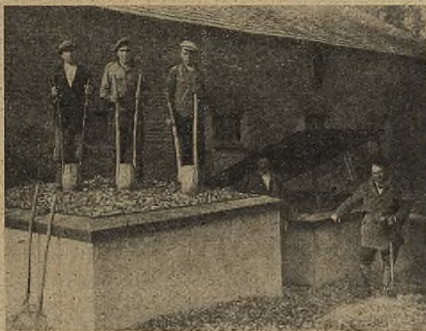
Ryc. 8. Zbiorniki we Wrocławiu koło Lwowa, zbudowane przy północnej ścianie obory, dla ochrony przed promieniami słonecznymi.
