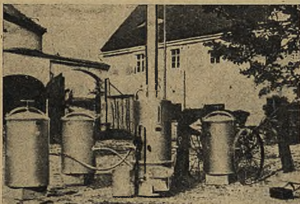
Ryc. 2. Kolumna do parowania ziemniaków w czasie pracy.
