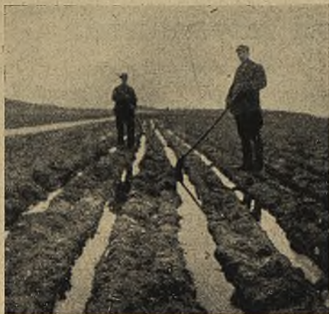
Rozprowadzanie wód ścieków bruzdami po polu irygacyjnym (wg. Steina).
