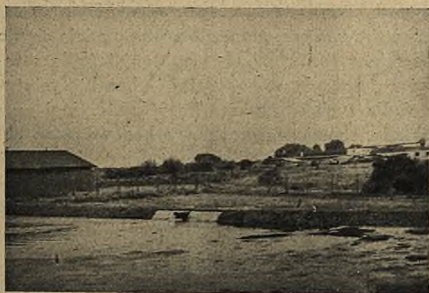
Napełnianie kwatery ściekami. Zdjęcie autora.
