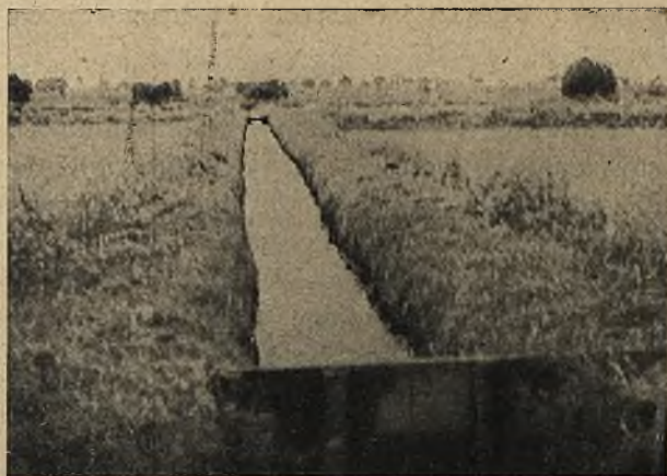
Rowy i zastawy do spiętrzania wód ściekowych Zdjęcie autora.
