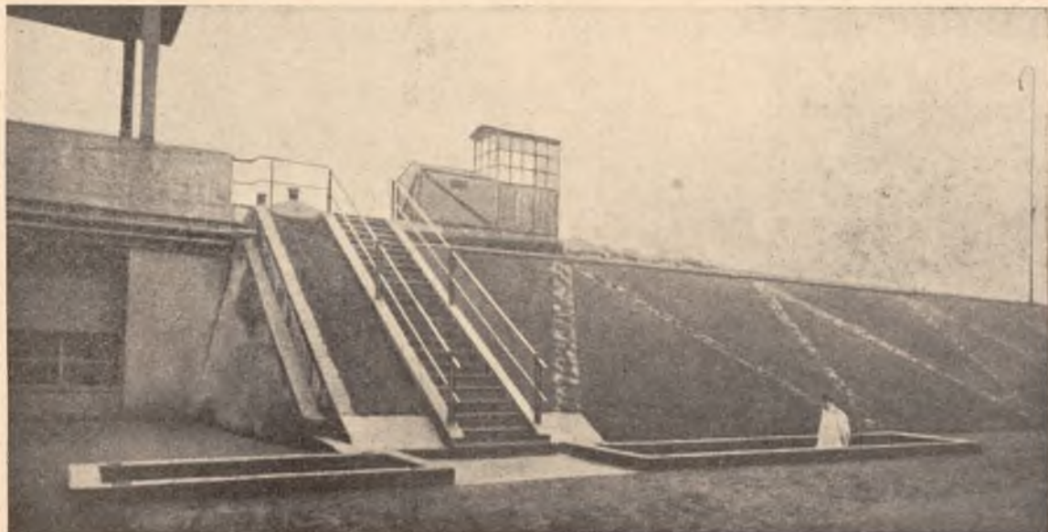
Rys. 3. — Wejście do schronu zbudowanego pod nasypem.
