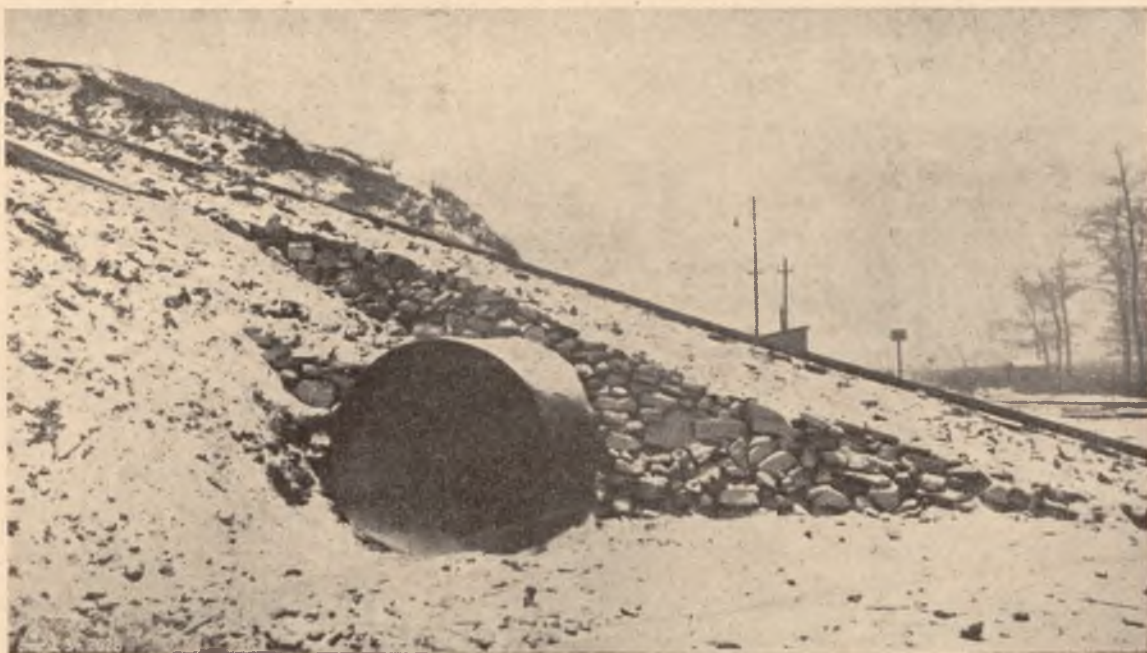
Rys. 4. — Stary zbiornik po benzolu przed przeróbką i zasypaniem.
