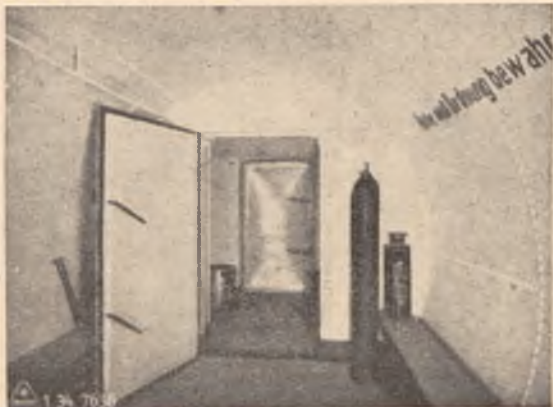
Rys. 5. — Wejście do schronu, urządzonego w starym zbiorniku po benzolu.
