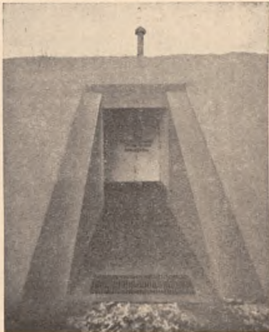
Rys. 7. — Betonowane wejście do schronu.
