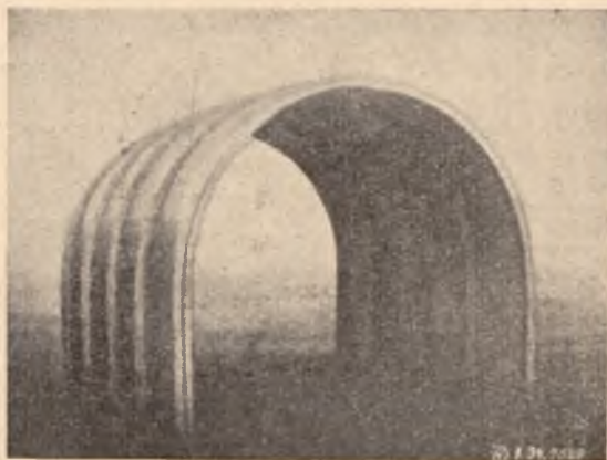
Rys. 8. — Stalowe sklepienie schronu.
