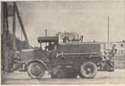
Rys. 9. — Polewaczka-zamiataczka samochodowa, przystosowana do celów odkażania.
