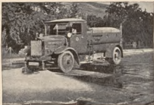
Rys. 7. — Polewaczka o pojemności 5.000 l podczas pracy. Widać zmywaki ustawione i pracujące na wprost i na boki.
