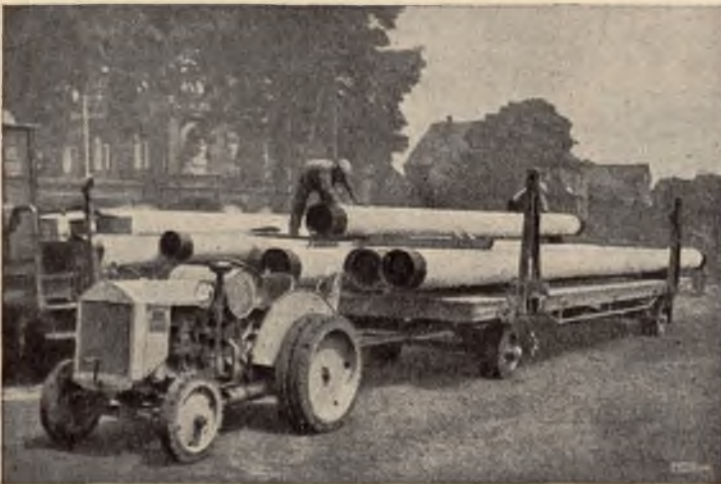
Rys. 6. — Zastosowanie ciągnika oraz platform samochodowych f. „Hanomag“ do przewozu materiałów kanalizacyjnych.
