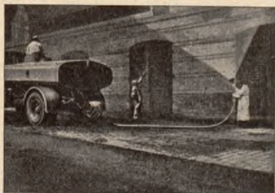
Rys. 12. — Zastosowanie dyszy „deszczowej“ dla celów odkażania budynków.
