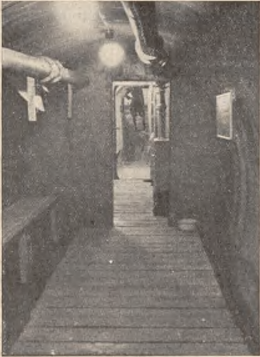
Rys. 15. — Wnętrze fragmentu schronu z segmentów betonowych.
