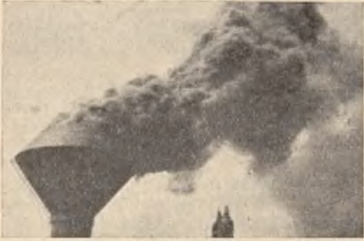
Rys. 5. — Zadymianie z parowozu wąskotorowego. Parowóz stoi w miejscu; do paleniska wrzucano 3 brykiety z masy dymotwórczej.
