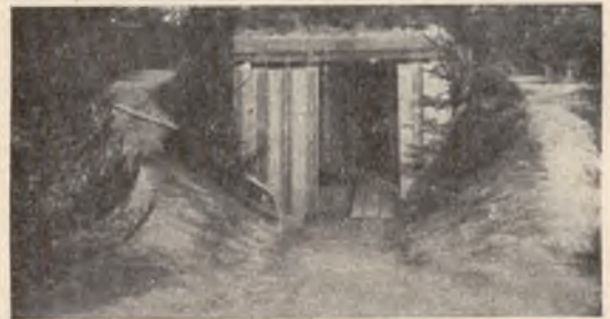
Rys. 16. — Fragment schronu ze szpuntpali.
