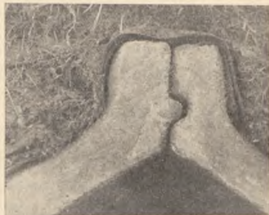
Ryc. 13 Schron członowy żelbetowy „Wibbet“ (szczegół połączenia elementów)
