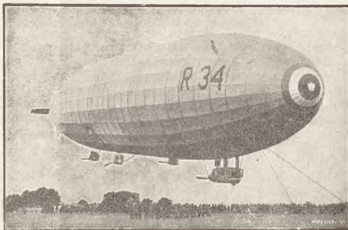
BALON STEROWIEC starej konstrukcji.
