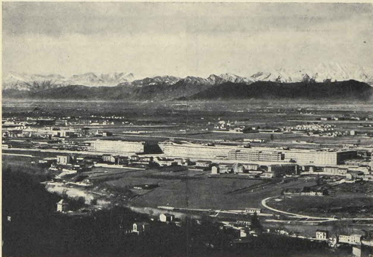
Ogólny widok fabryki.
