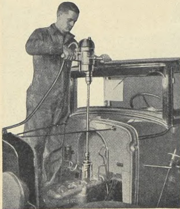
Rys. 9. Szlifowanie gładzi cylindrów na samochodzie.
