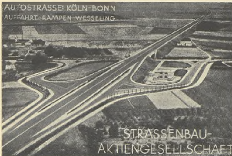
Autostrada Kolonia—Bonn (zdjęcie lotnicze) przecina normalną szosę. Typowe skrzyżowanie autostrady z innym torem komunikacyjnym i połączenie obu dróg zapomocą ramp dojazdowych.
