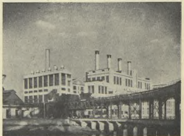
Widok budynków kotłowni.
