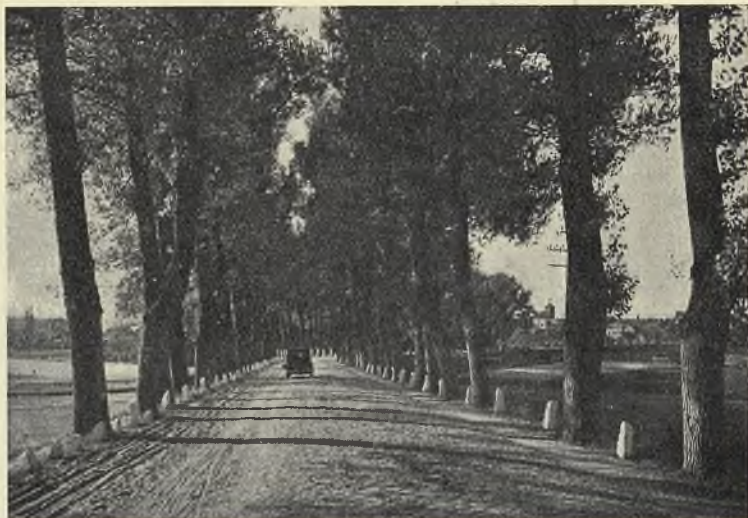
Szosa o nawierzchni z grubej kostki kamiennej.
