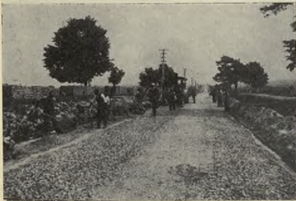
Pogrubianie szosy tłuczniowej pod ulepszoną nawierzchnię z klinkieru
