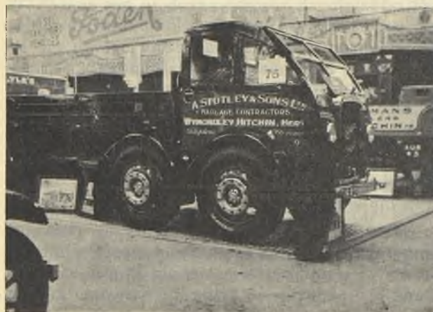
Wóz ciężarowy 15 ton, Foden, czteroosiowy, z silnikiem 100 KM, 6-cylindr. Gardner-Diesel.
