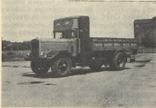
Ciężarówka Fiat 634 G z sześciocyndrowym silnikiem na gaz drzewny.
